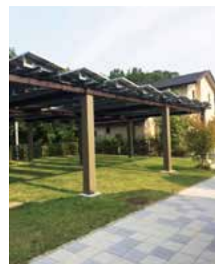
太陽光パネル
